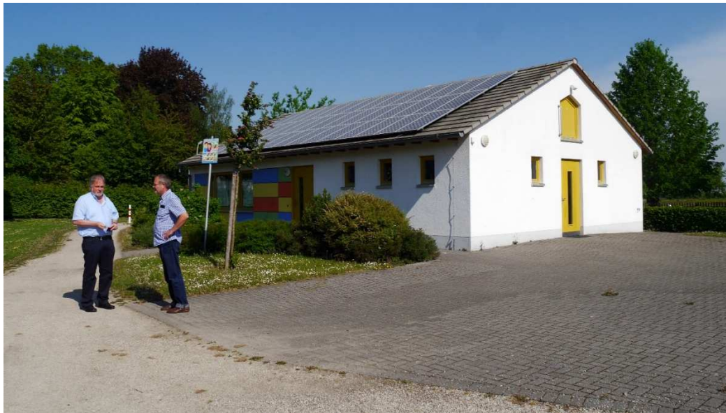
Abb. 11: Das Jugendhaus wurde in Eigenarbeit errichtet.
