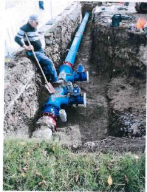
Sanierung der Trinkwasserleitung (DN 300) in Beckum, Pflaumenallee, im September 2021.
