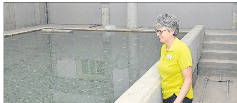
Im Kurmittelhaus ist das neue Therapiebecken im Bau. Jutta Möllmann steht im Therapiegang, in dem Anleitungen auf Augenhöhe erfolgen werden.
