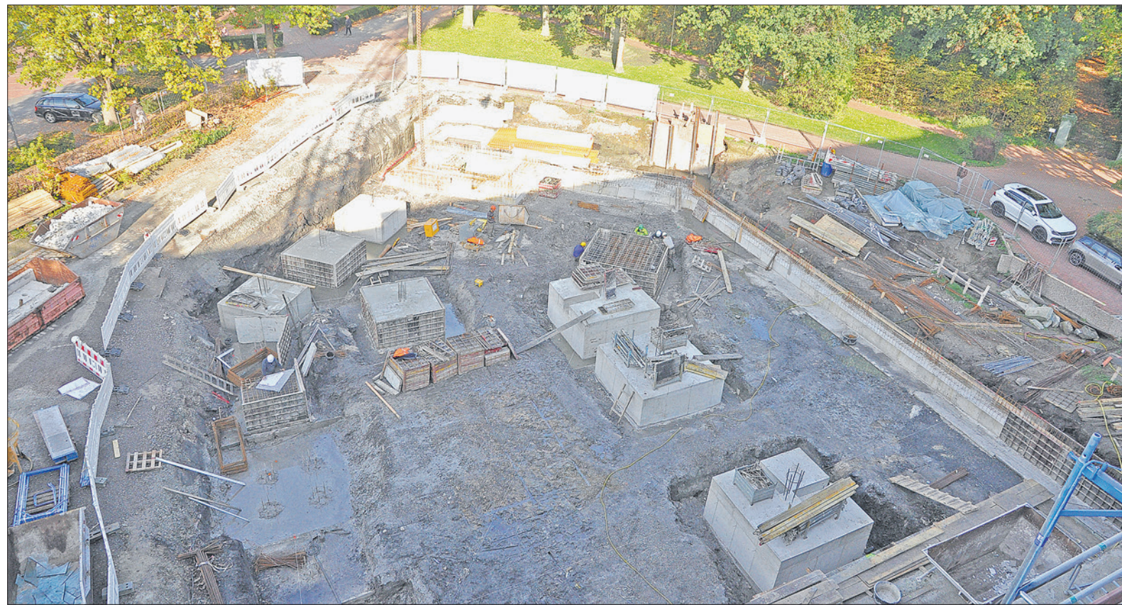
Hier entsteht der Anbau von „Haus Rosenau“. Ist er Ende 2020 fertig, verfügt er über eine Kapazität von 76 Betten.
