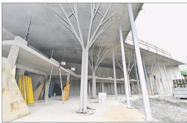
Wie Bäume sind die Pfeiler für die Dachkonstruktion des Ruhehauses verzweigt.
