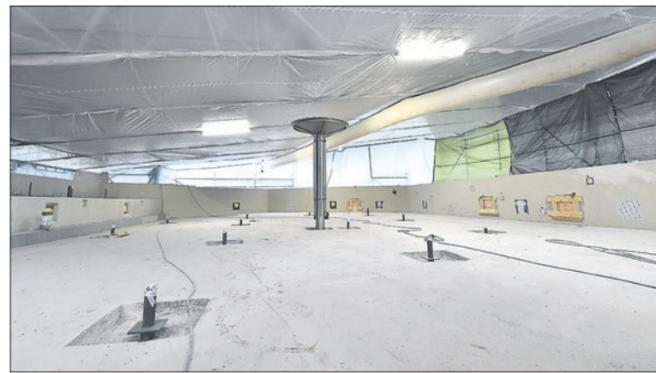
Anschlüsse für Massagedüsen oder Scheinwerfer sind in den neuen Außenbecken schon installiert.
