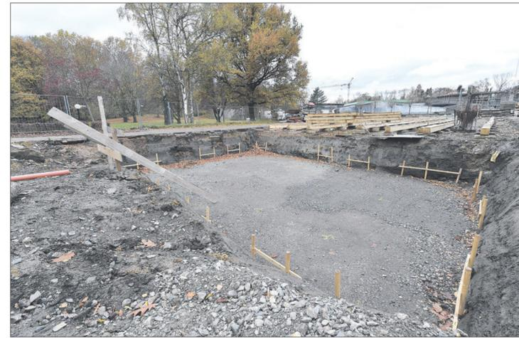
Hier entsteht das Fundament für den Vorbau. Die Position des späteren Aufzugs ist bereits grün markiert. Foto: Schmalenbach
