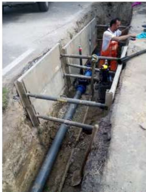
Sanierung der Trinkwasserleitung (DN 100) in Wadersloh, Stromberger Straße, im Juli 2022.
