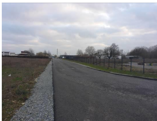
Abb. 14 Blick auf die südliche Anschlussstelle zum bestehenden Gewerbepark.
