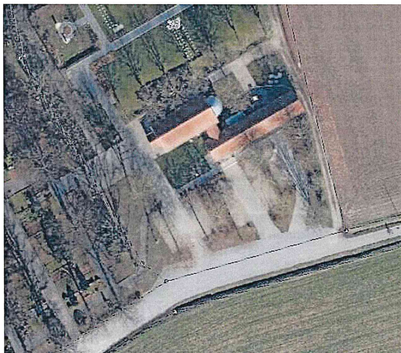
Abb. 6 Luftbild Friedhofshalle mit Anbau. Ohne Maßstab
