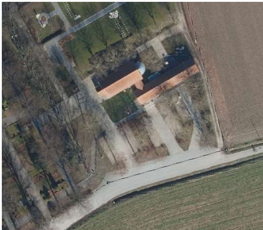
Abb. 6 Luftbild Friedhofshalle mit Anbau. Ohne Maßstab
