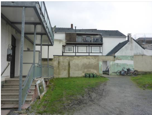
Abb. 7 Rückansicht der beanspruchten Gebäude. Blick Richtung Osten.
