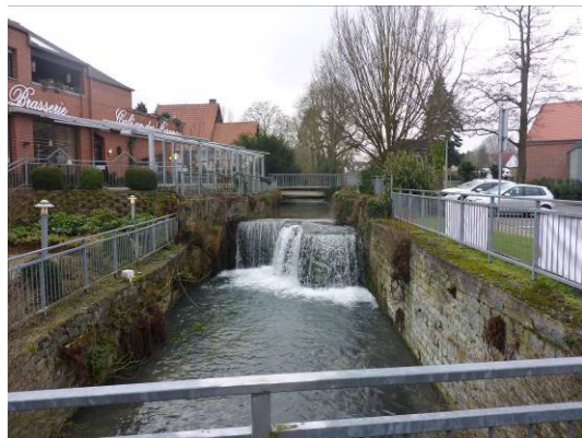
Abb. 13 Verlauf der Rosenau südwestlich des Plangebiets.
