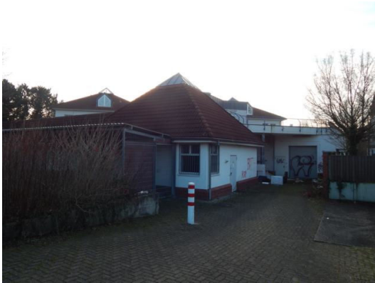
Abb. 3 Rückwärtige Ansicht des Gebäudes.
