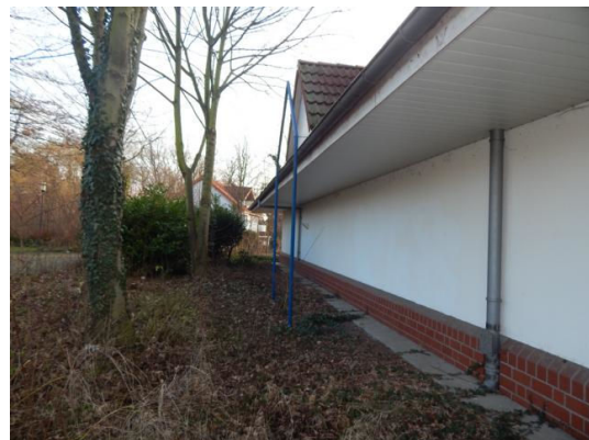
Abb. 2 Östliche Ansicht des Gebäudes.
