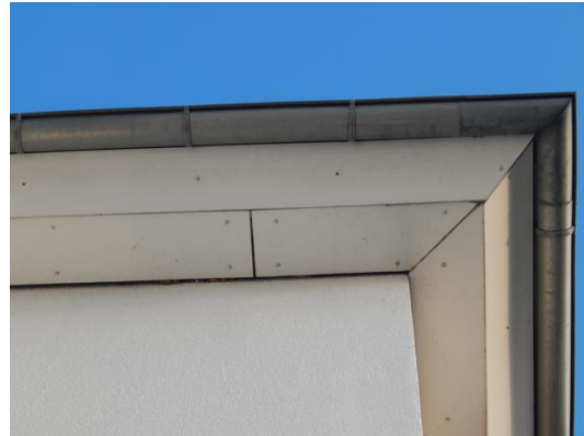
Abb. 4 Verkleidung des Dachüberstands im Eingangsbereich.
