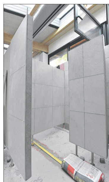
Neue Trennwände in den Duschen entstehen.
