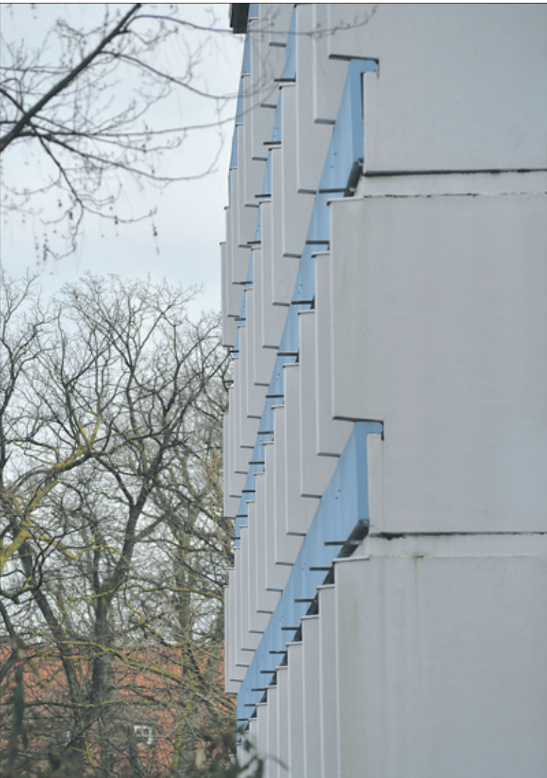
Die nicht eben schucke „Plattenbau-Optik“ am Eingang zum Kurpark soll verschwinden.
