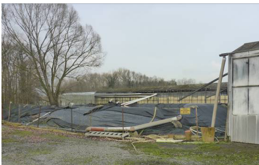
Abb. 12 Regenwasserbecken im Westen des Plangebiets.
