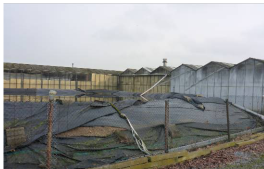
Abb. 13 Regenwasserbecken im Westen des Plangebiets.
